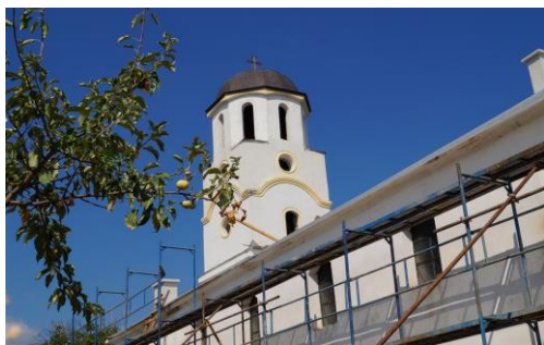
Ремонтът на черквата „Св. Георги“ в с. Микрево Ще завърши през октомври
